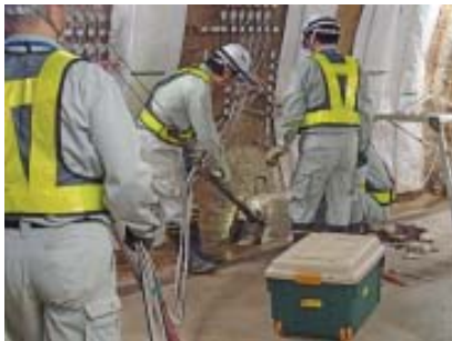
ボーリング孔内への試験装置設置作業
